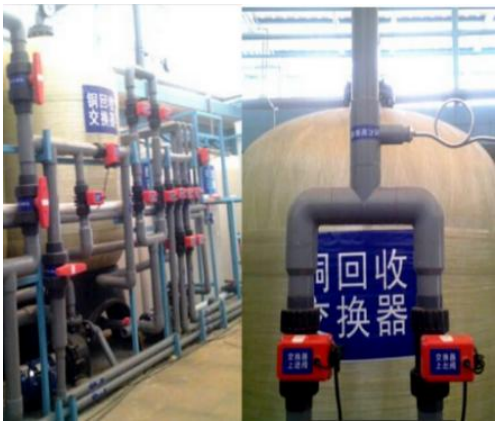
图 3-15 润景球阀应用于 线路板铜回收设备
