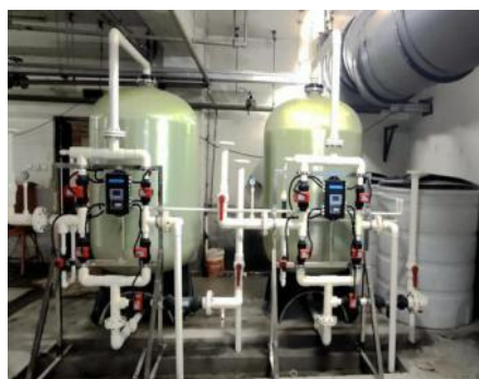
图 3-25 润景球阀应用于软化水设备
