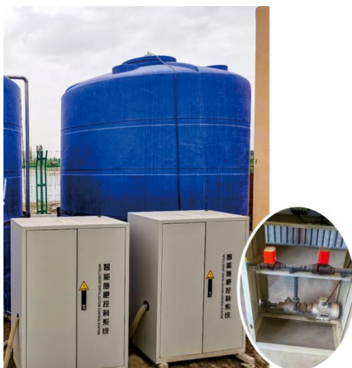
图 4-29 新疆石河子某种植场智能施肥控制系统采用润景陶瓷硬密封球阀
