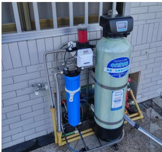
图 2-23 山泉水过滤器安装现场
