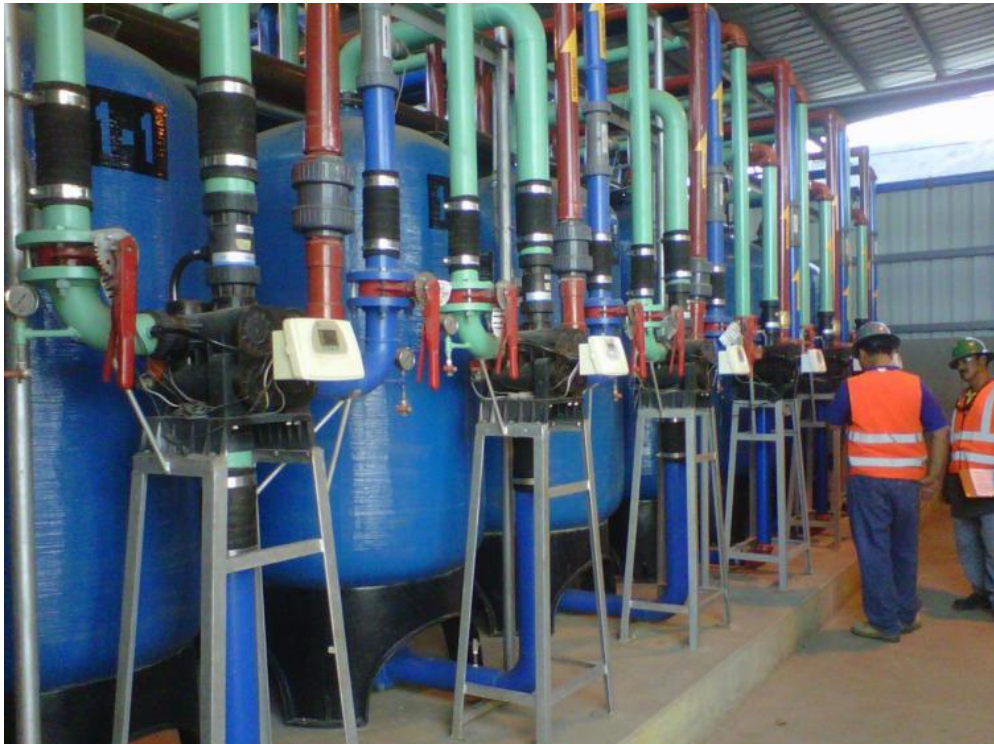
图 1-7 危地马拉某养禽场采用 F112B 控制阀
