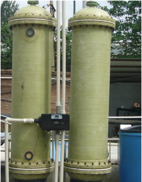
图 1-29 F88C 应用于 河南新乡某建材公司软化系统
