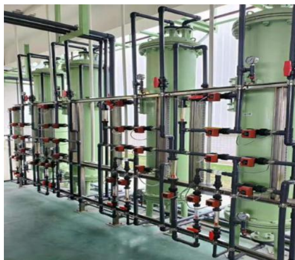
图 3-32 润景球阀应用于阴阳床设备
