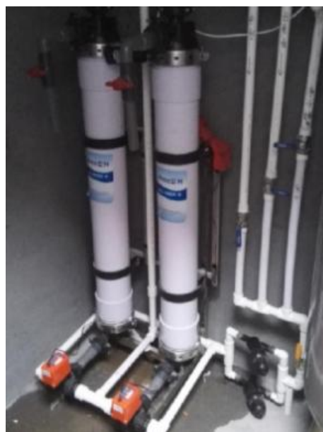
图 3-28 润景球阀应用于超滤设备
