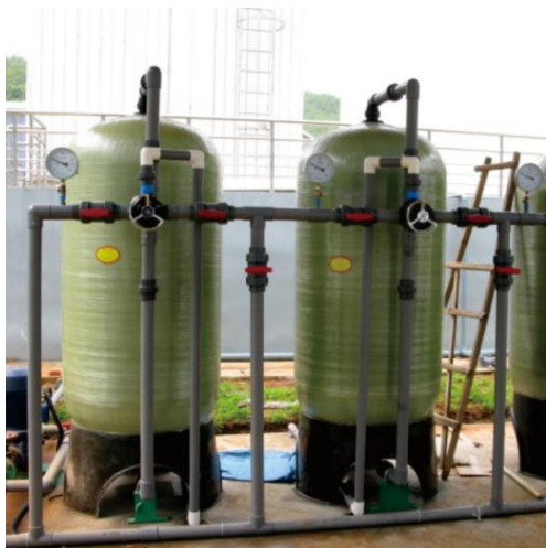
图 1-16 N64D 应用于昆明某酿酒厂软水系统 图 1-17 F77AS 应用于伊朗某医院 60m 3 /h 软水系统
