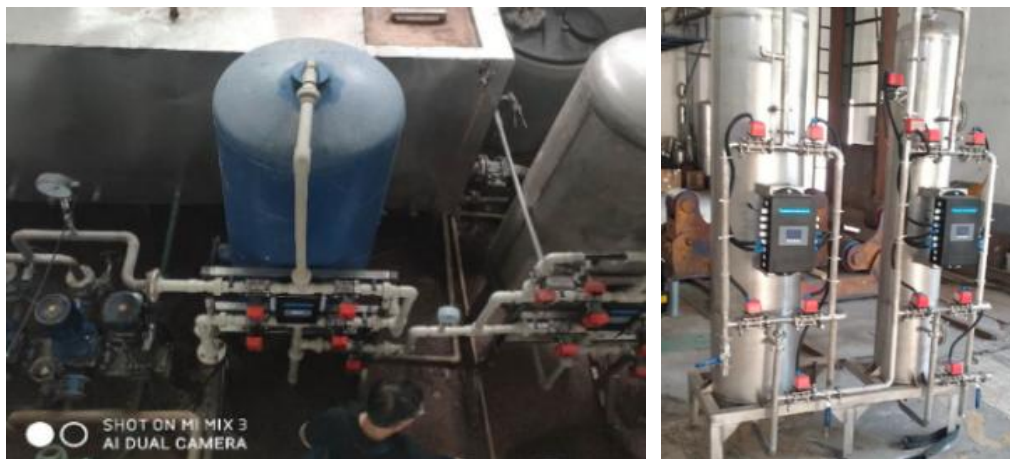
图 3-26 润景球阀应用于热消毒水处理设备和高温水过滤设备
