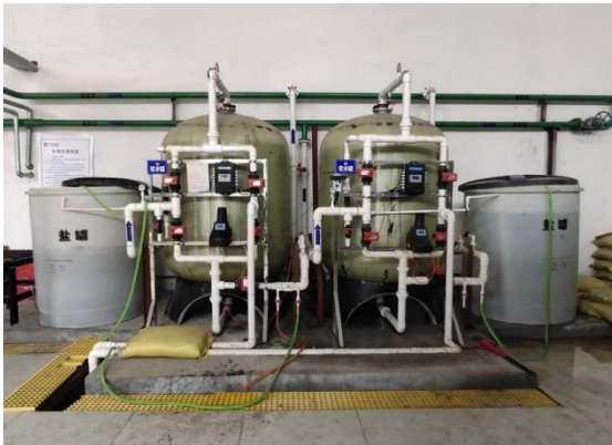
图 1-59 采暖蒸汽锅炉软水设备图
