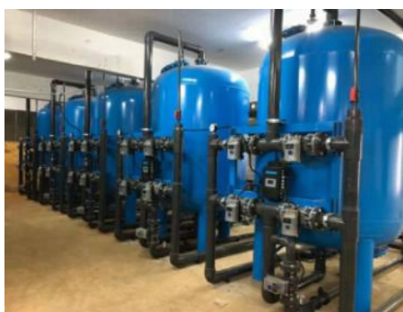
图 3-23 润景球阀应用于除铁锰设备
